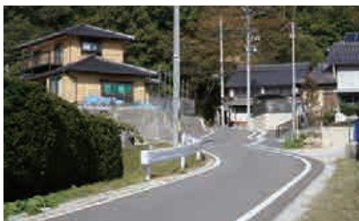
▲改良工事が完了した村道
