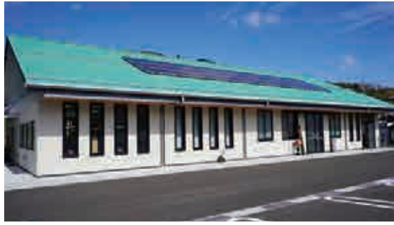
▲完成した福祉施設
